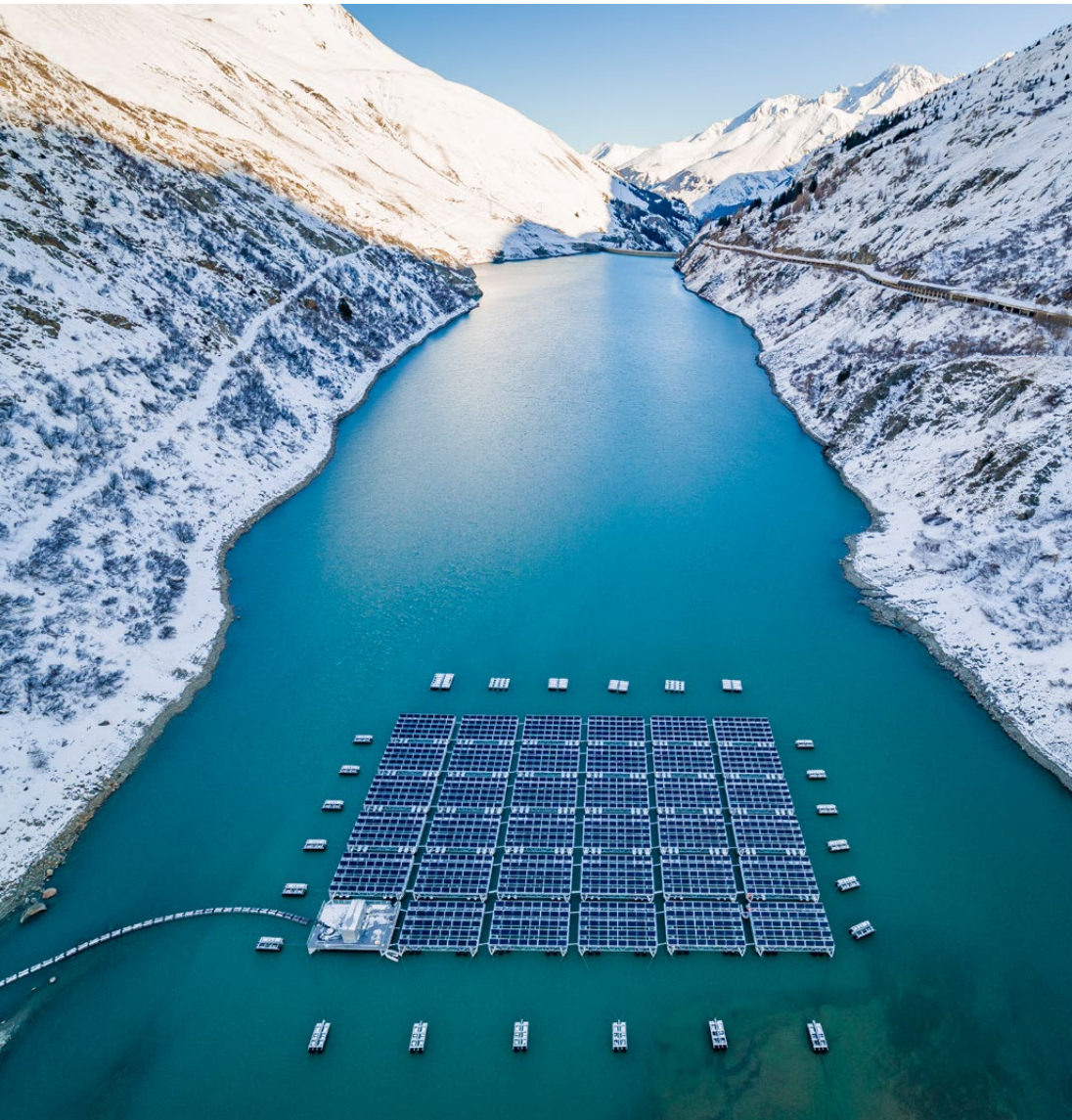
Source : Romand Energie. Installation solaire flottante sur le lac des Toules, dans la commune valaisanne de Bourg-Saint-Pierre.
